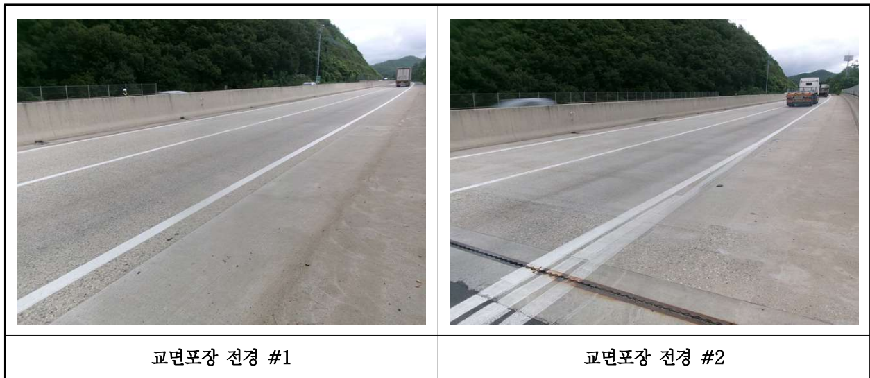
【사진 1.3.46】 교면포장 전경
