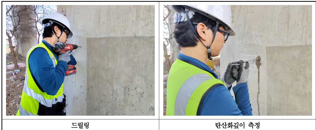
【사진 1.4.3】 탄산화 깊이 측정 현장사진
