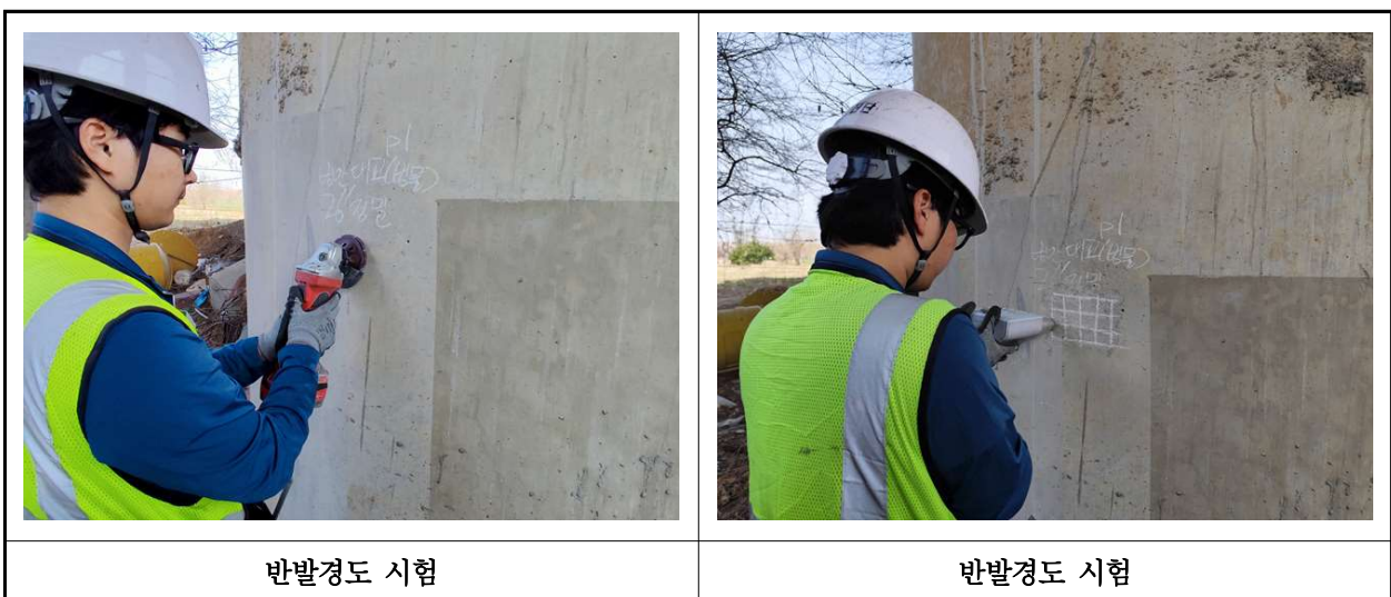
【사진 1.4.2】반발경도시험 현장사진
