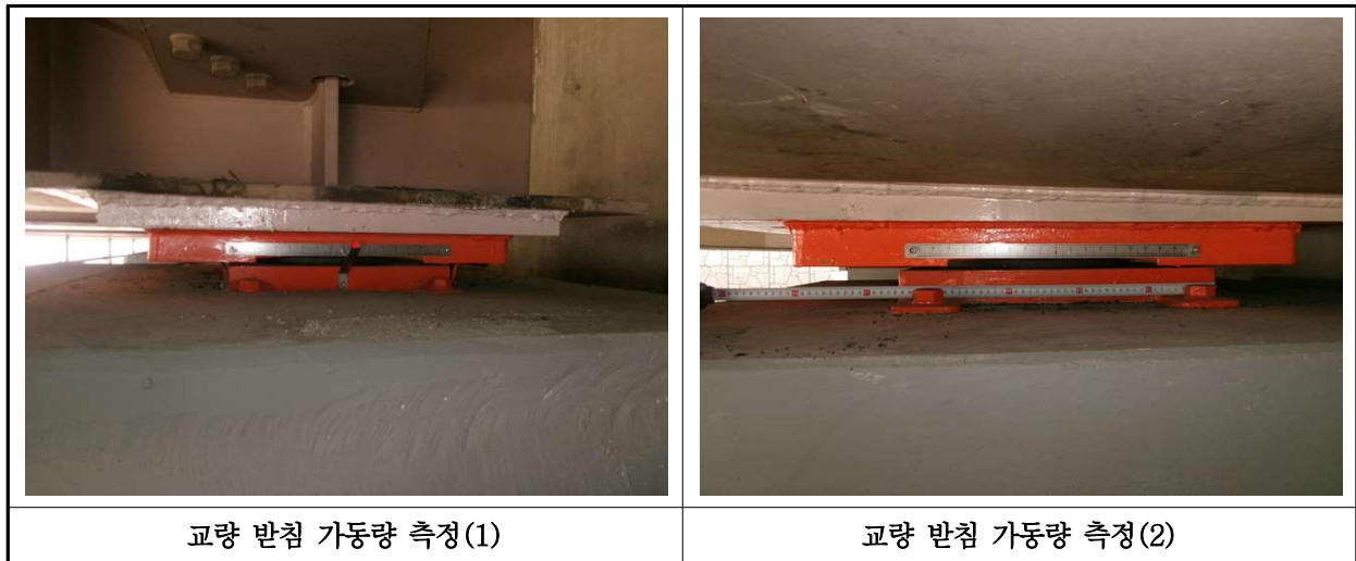
【사진 1.3.15】 교량받침 이동량 측정
