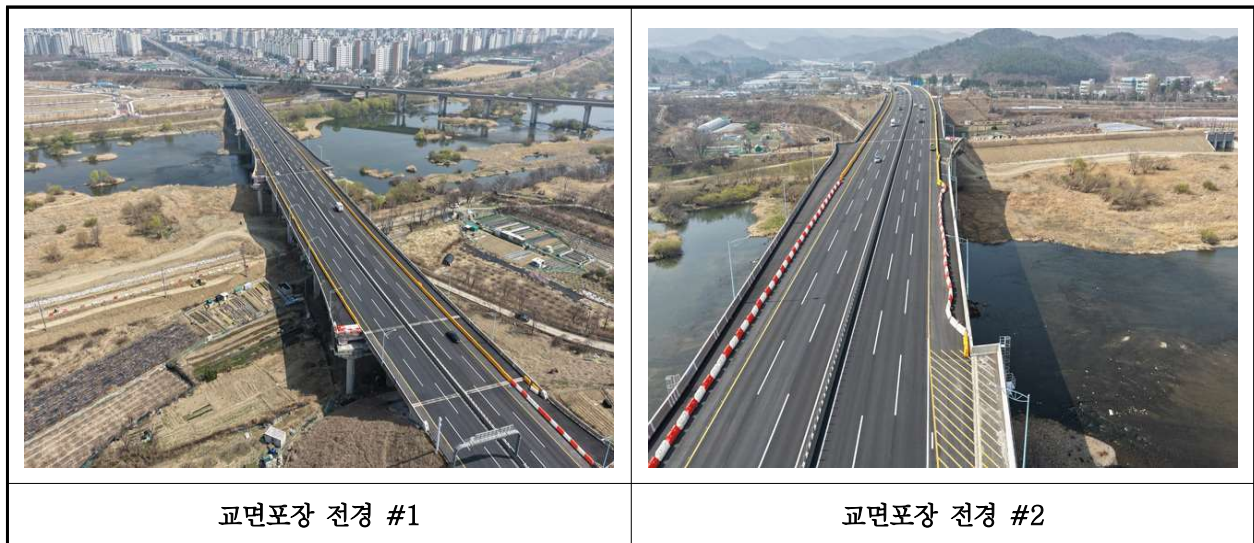
【사진 1.3.19】 교면포장 전경
