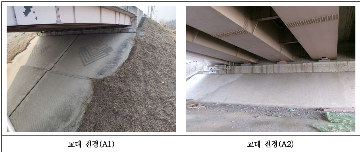
【사진 1.3.8】 교대 전경
