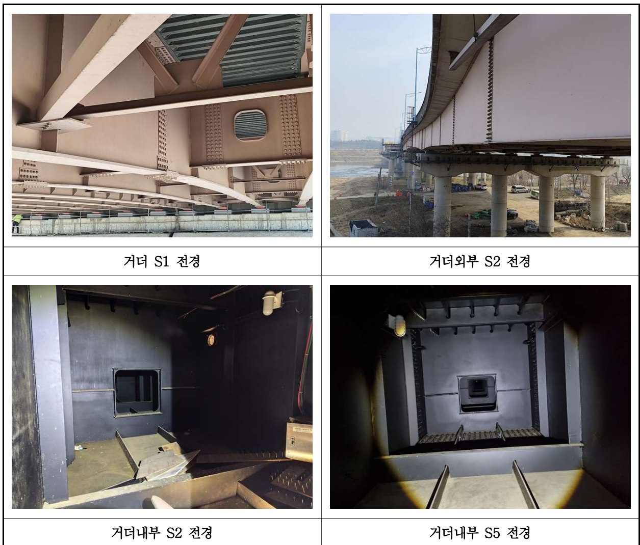
【사진 1.3.4】 거더 전경
