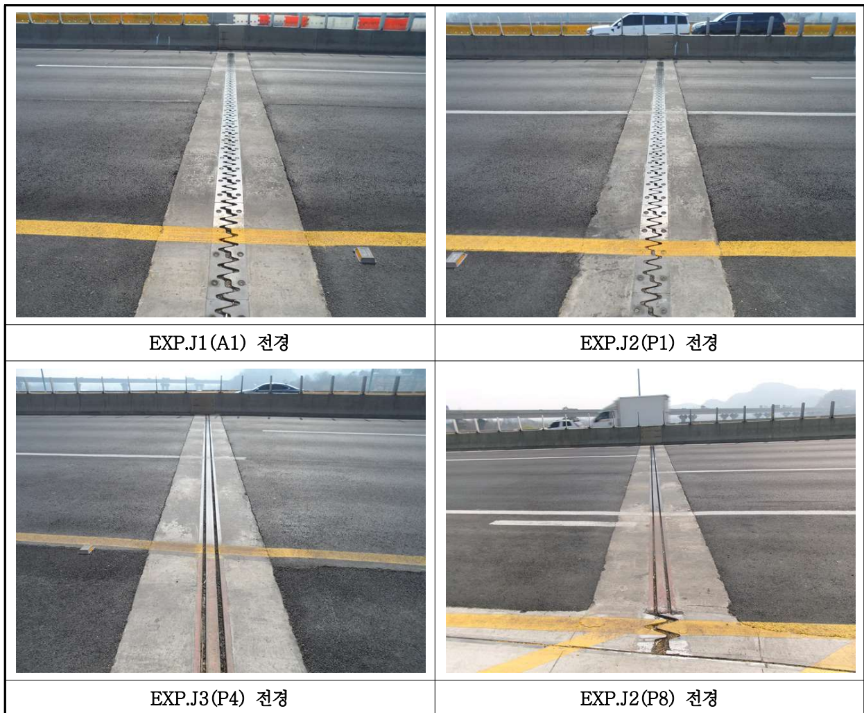
【사진 1.3.16】 신축이음장치 전경
