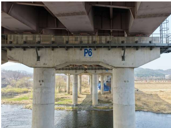
교각 P6 코핑부 상태현황
