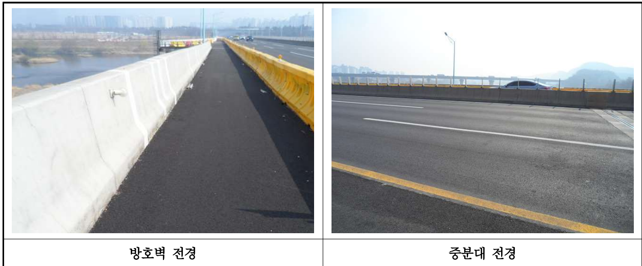
【사진 1.3.23】 방호벽 및 중분대 전경
