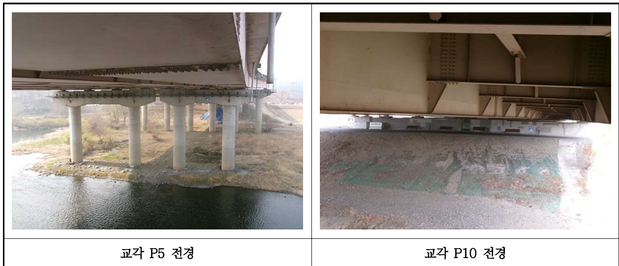
【사진 1.3.10】 교각 전경
