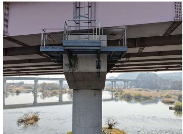
교각 P6 코핑부 상태현황
