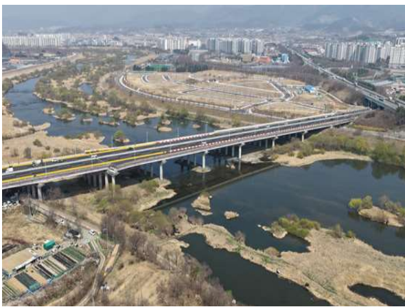
하부 교차 시설(금호강, 금호강변로) 전경
