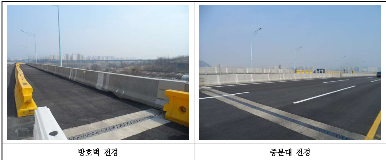
【사진 1.3.50】 방호벽 및 중분대 전경
