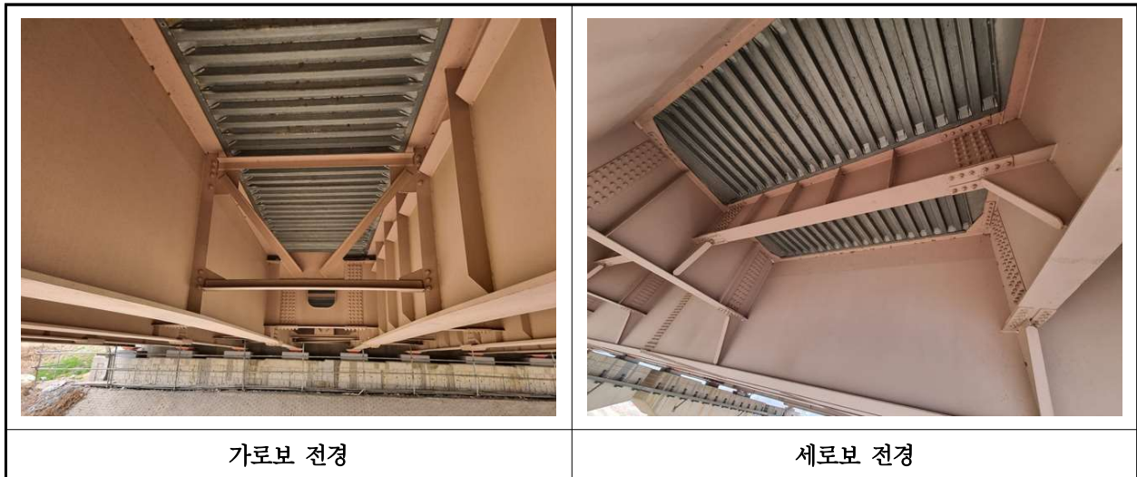
【사진 1.3.32】 가로보 및 세로보 전경
