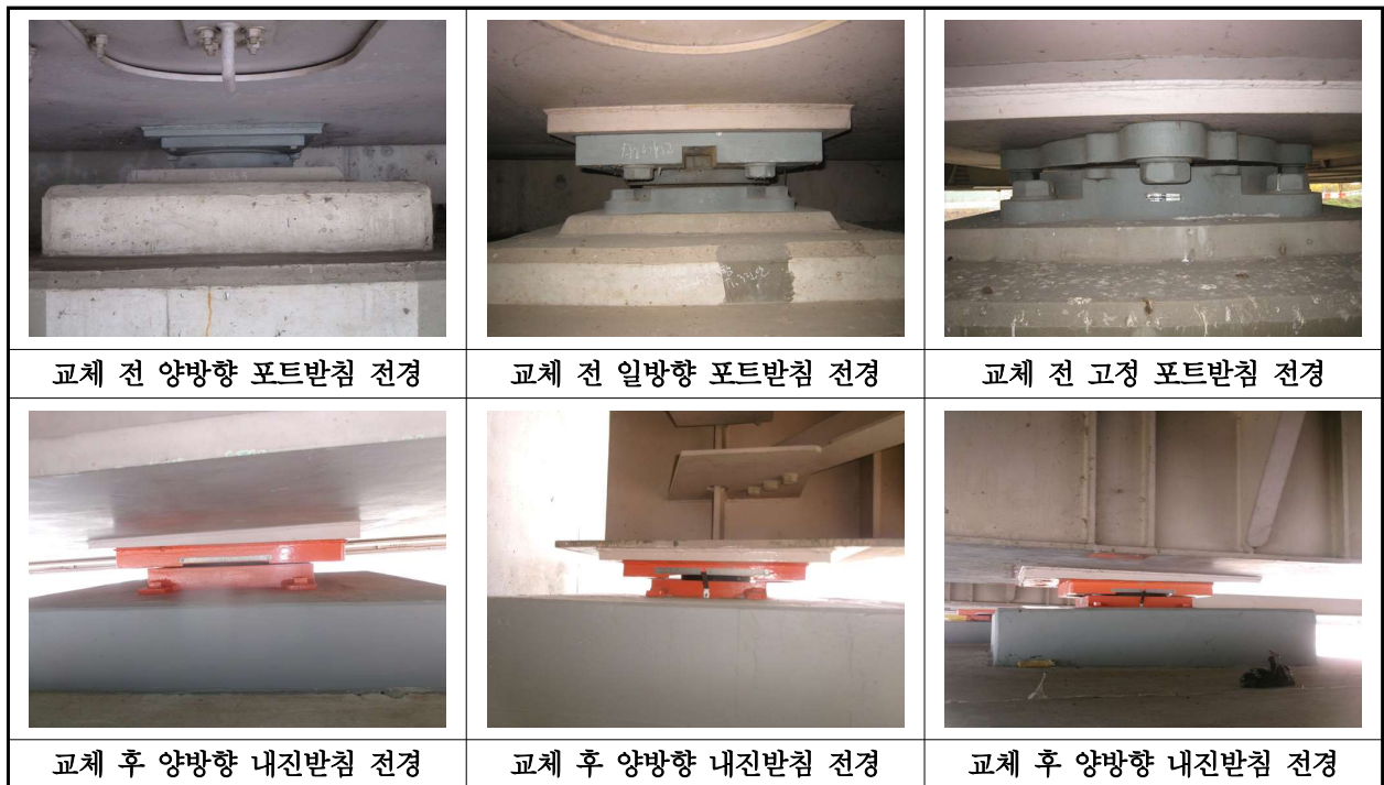
【사진 1.3.12】 교량받침 전경
