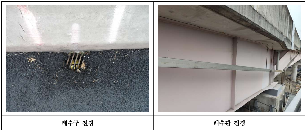
【사진 1.3.48】 배수시설 전경
