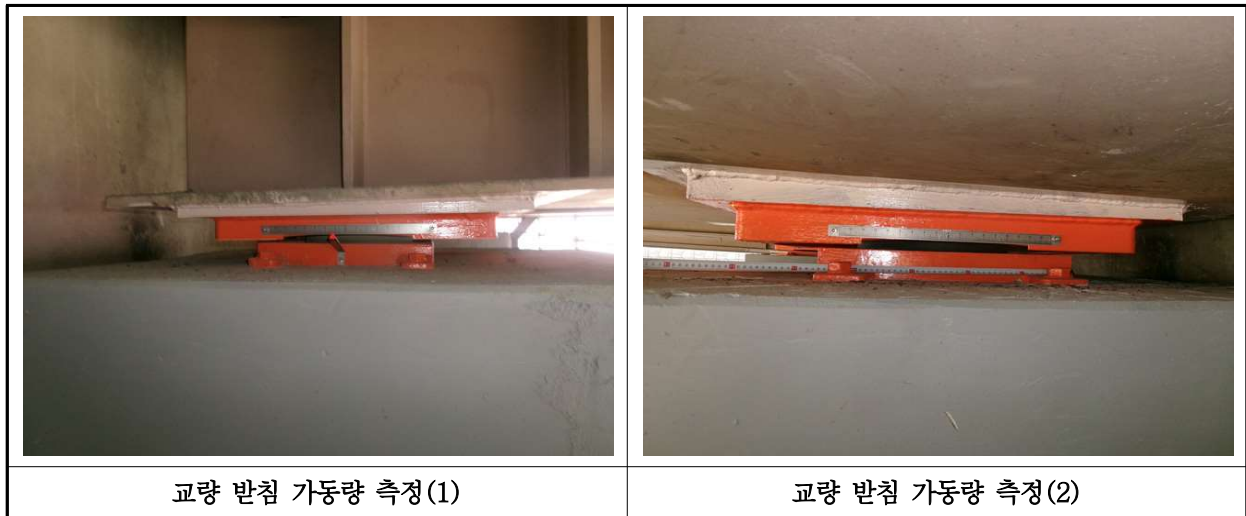
【사진 1.3.42】 교량받침 이동량 측정
