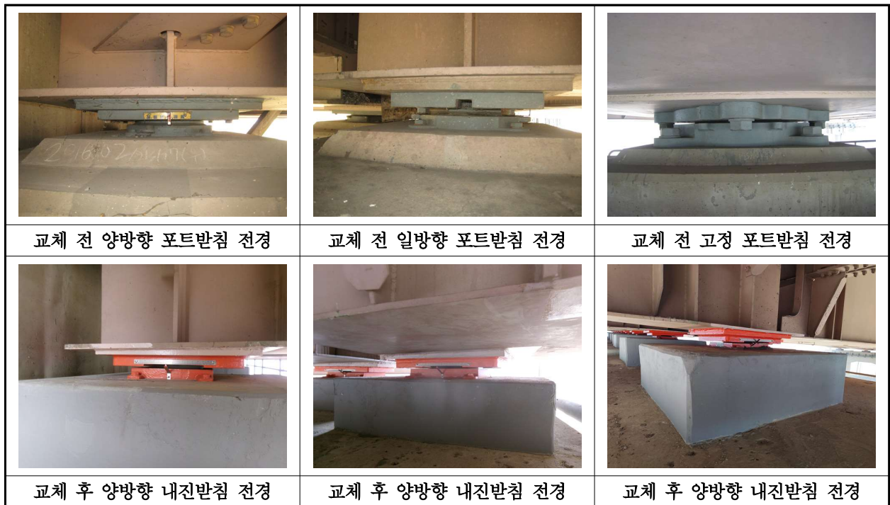
【사진 1.3.39】 교량받침 전경
