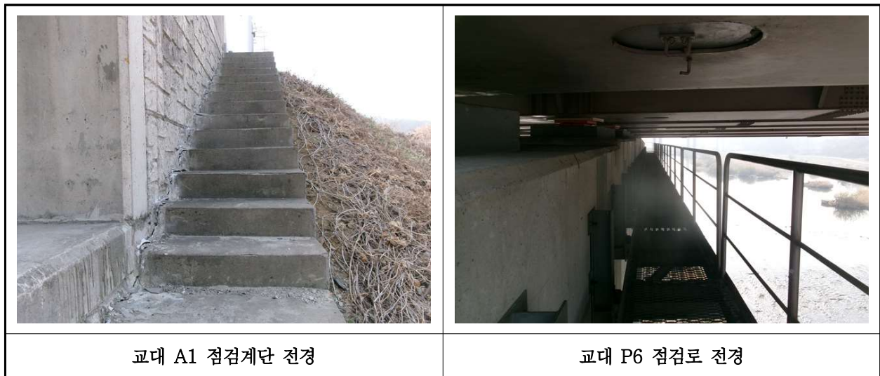
【사진 1.3.25】 교량 점검시설 전경
