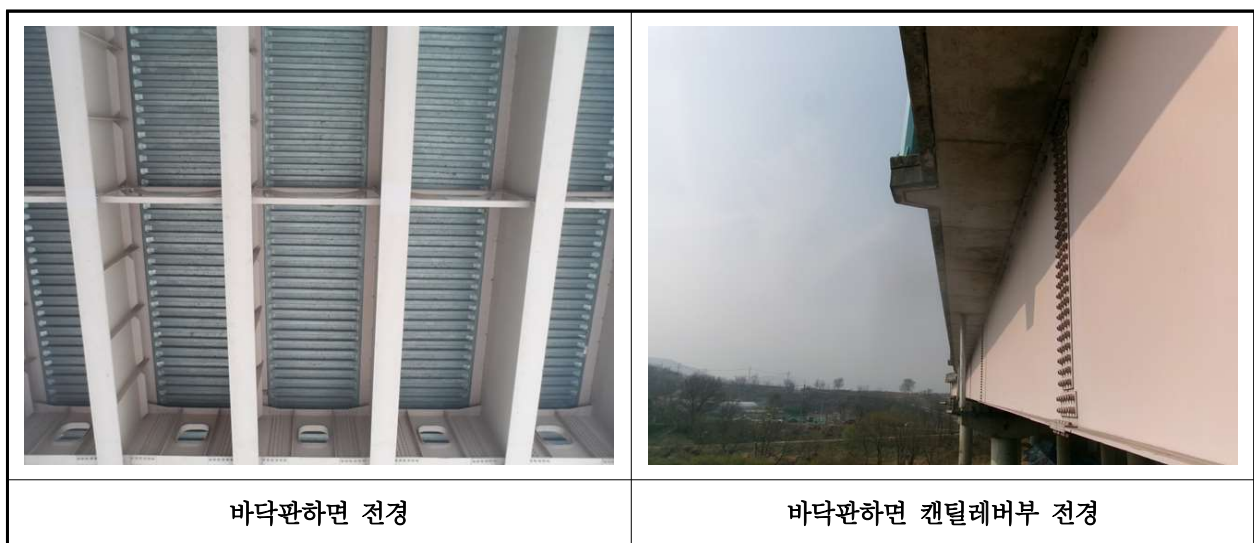
【사진 1.3.28】 바닥판하면 전경
