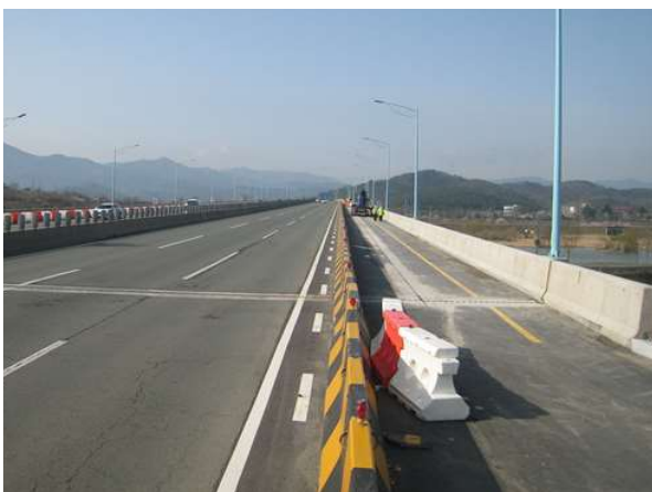
2024년 상부 범물방향 합류부 방호벽 제거구간 현황
