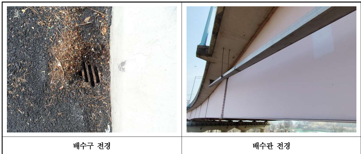
【사진 1.3.21】 배수시설 전경
