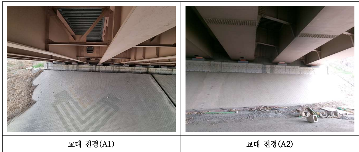
【사진 1.3.34】 교대 전경
