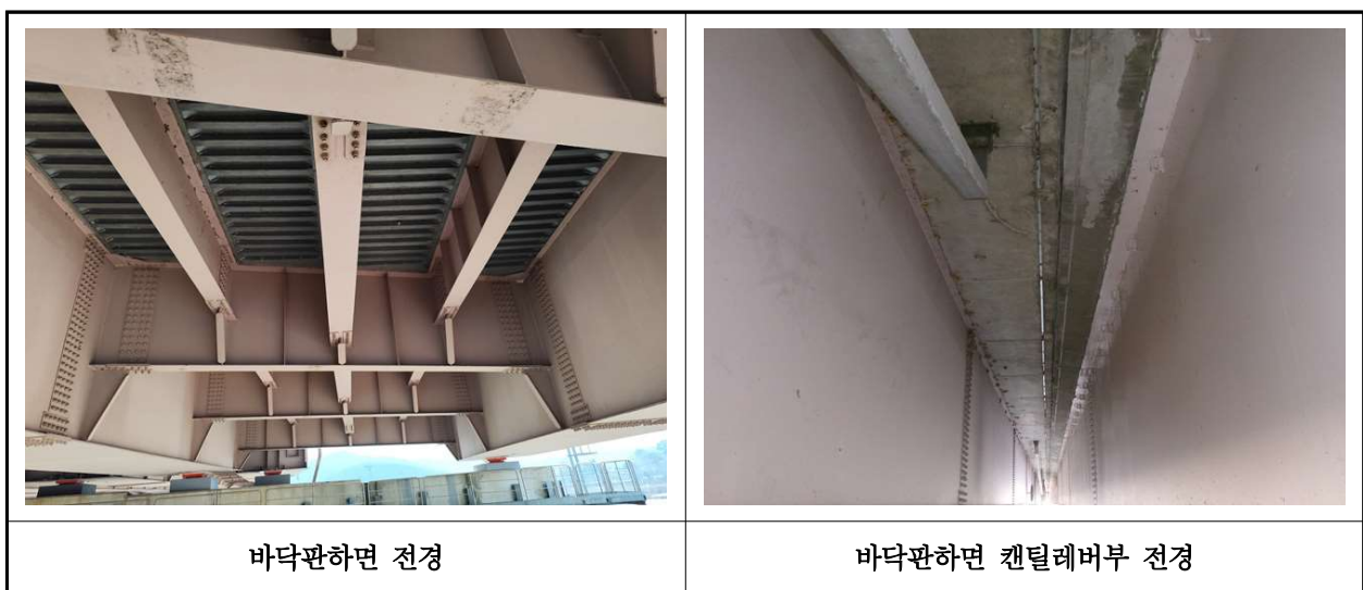
【사진 1.3.2】 바닥판하면 전경
