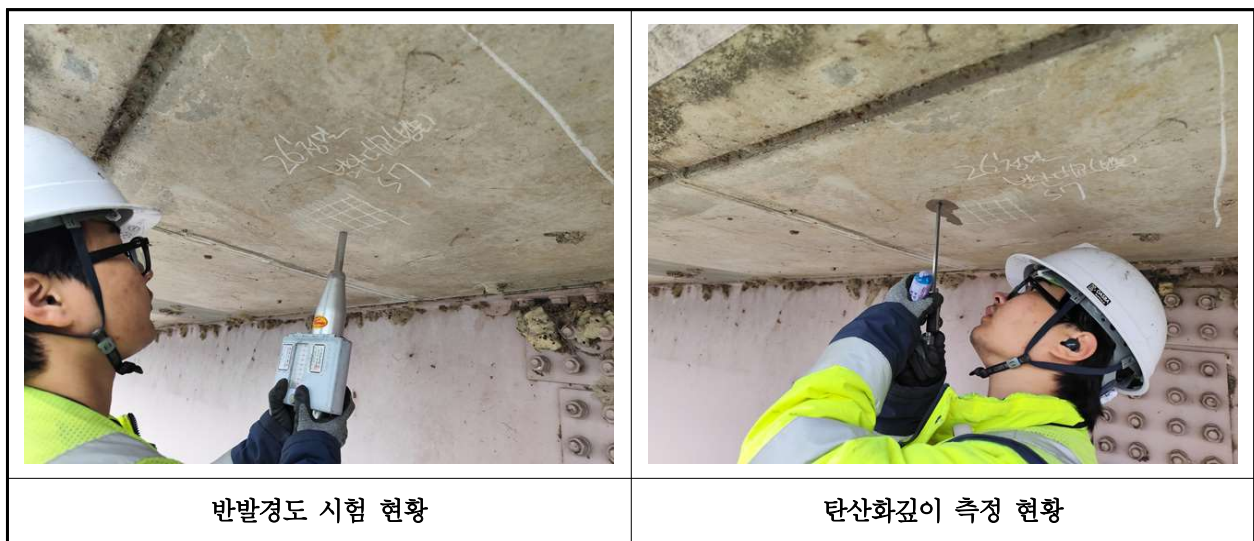
【사진 1.4.1】 콘크리트 내구성조사 현황
