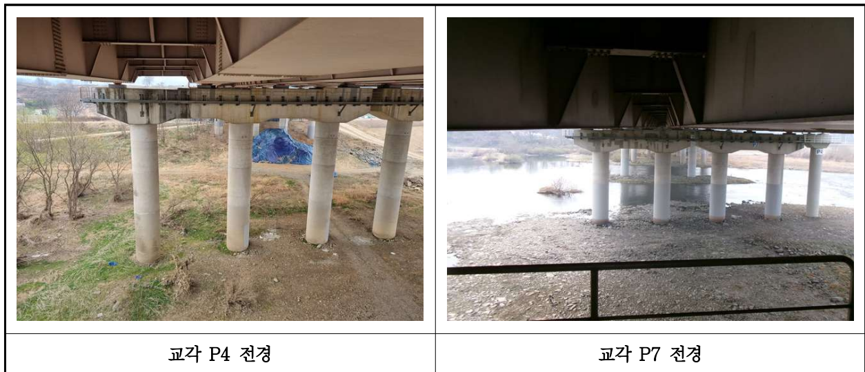
【사진 1.3.36】 교각 전경
