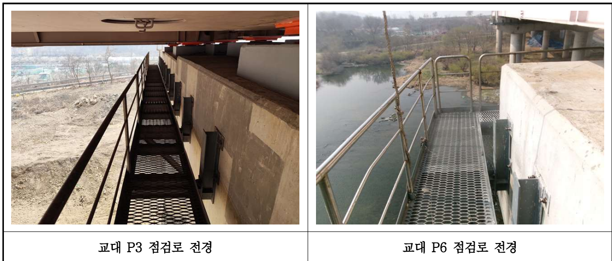
【사진 1.3.52】 교량 점검시설 전경
